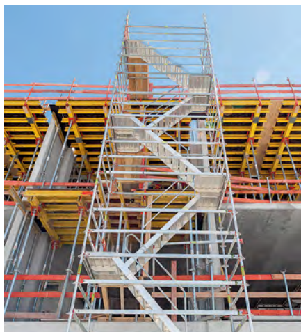
Schodnia PERI UP Flex z biegami aluminiowymi 75 współbieżna
