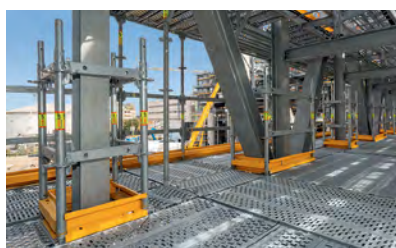
Płaska, szczelna i antypoślizgowa powierzchnia platformy
