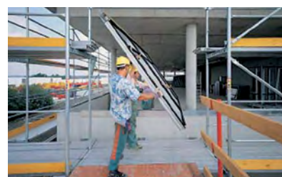
Możliwość otwarcia rusztowania dla zapewnienia transportu do środka budynku
