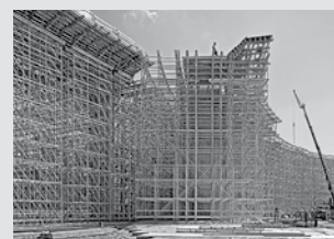
Rusztowania podporowe
