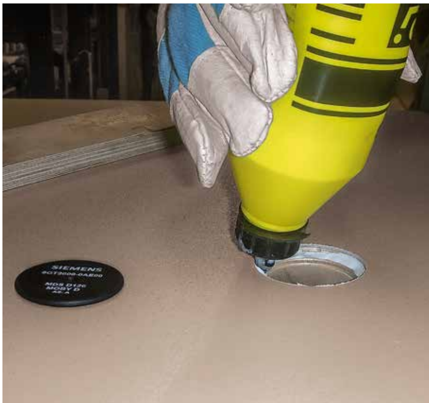
Wbudowanie chipów w białe PERI Pave można przeprowadzić w każdej chwili za pomocą zestawu naprawczego.
