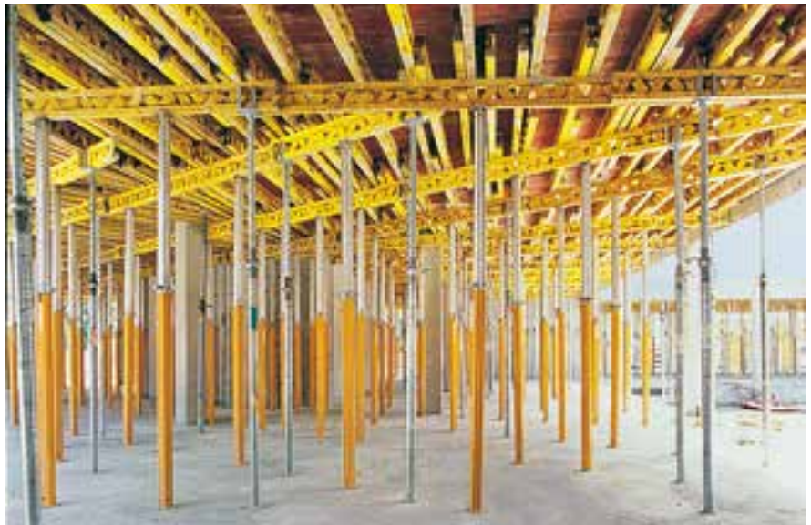
MULTIFLEX z użyciem podwójnych dźwigarów GT 24 dla optymalnego dopasowania do geometrii okrągłego zbiornika.
