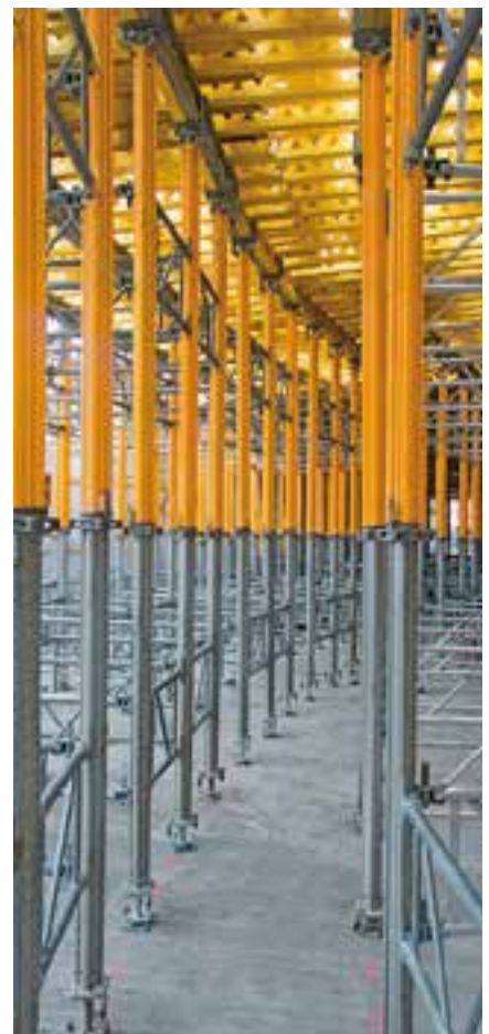
Poziomy ruszt nośny zbudowano z dźwigarów kratowych GT 24, zastosowanych jako podwójne dźwigary główne oraz rozdzielcze.
