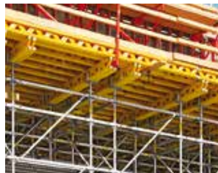
Podwójne dźwigary GT 24 zwiększają wykorzystanie nośności rusztowania podporowego PERI UP Flex na dużych wysokościach.
