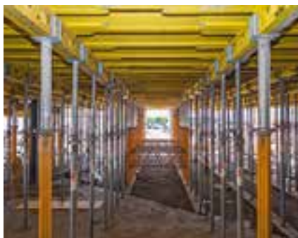
Zastosowanie dźwigarów GT 24 zmniejsza zużycie dźwigarów, rygli stalowych oraz podpór, a to oznacza redukcję kosztów materiału i robocizny.
