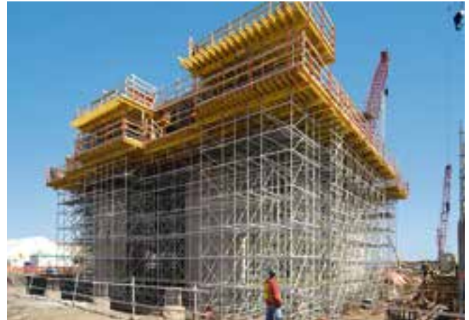
Systemy MULTIFLEX i PERI UP Rosett niezawodnie przenosiły na podłoże wysokie obciążenia od masywnych elementów konstrukcyjnych z wysokości od 10 m do 12 m.
