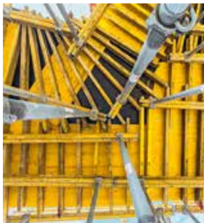
MULTIFLEX z użyciem podwójnych dźwigarów GT 24 dla optymalnego dopasowania do geometrii okrągłego zbiornika.
