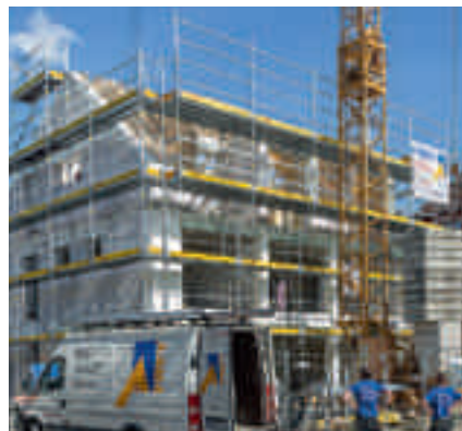
Realizacja budynku biurowo-mieszkalnego, Frickenhausen, Niemcy
