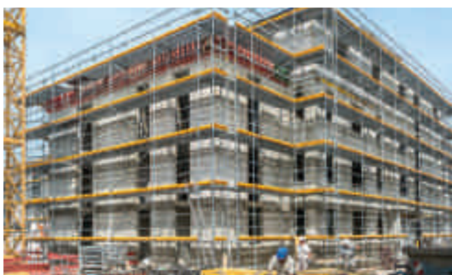
Budowa osiedla mieszkalnego przy Killisfeldstraße, Karlsruhe, Niemcy
