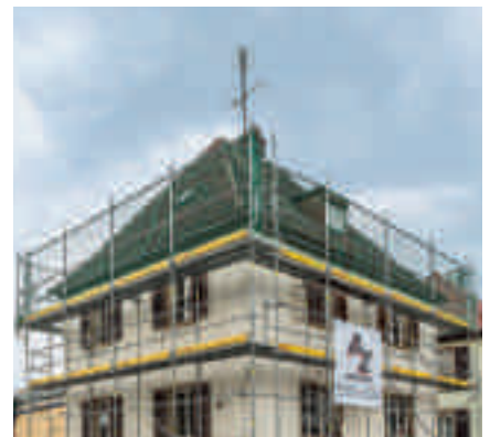
Remont kamienicy, Landau, Niemcy
