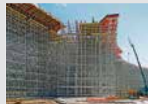
Rusztowania podporowe
