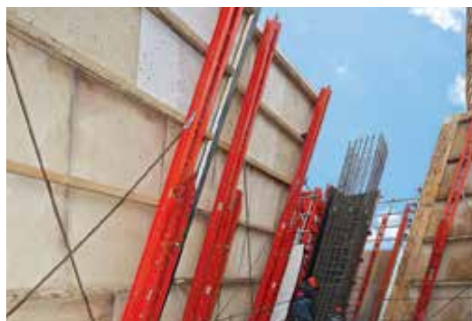
Szyny wspinania osłon zabezpieczających RCS podążają za skośną geometrią budowli. Specjalne uchwyty stropowe zapewniają bezpieczne połączenie szyn z budowlą.
