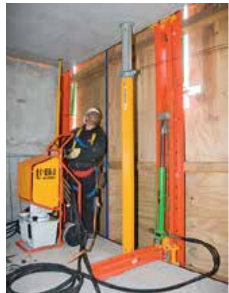
Jednostki są podnoszone z prędkością 1 m/min.
