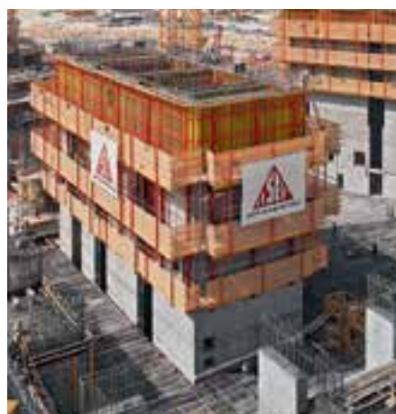
Bezpieczeństwo wykonywania robót na i pod pomostami RCS dzięki zabezpieczeniu bocznemu oraz pełnemu osłonięciu.
