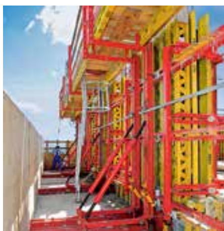
W tej realizacji deskowanie słupów obwodowych wspina się samoczynnie dzięki systemowi RCS. Osłonięcie pomostów zabezpiecza jednocześnie przed wiatrem i oddziaływaniem czynników atmosferycznych.
