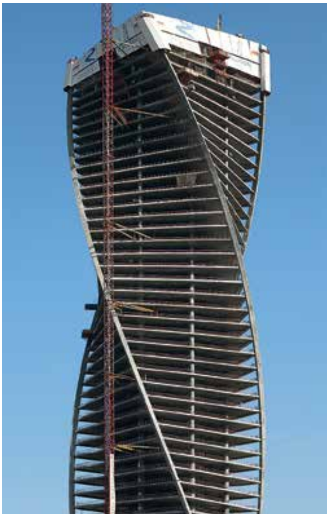
Evolution Tower wkręca się w moskiewskie niebo, wznosząc się na wysokość prawie 250 m i wykonując przy tym obrót o 150 stopni. Wysoki stopień bezpieczeństwa zapewniają ukośnie wspinające się bez użycia żurawia jednostki osłon zabezpieczających RCS.
