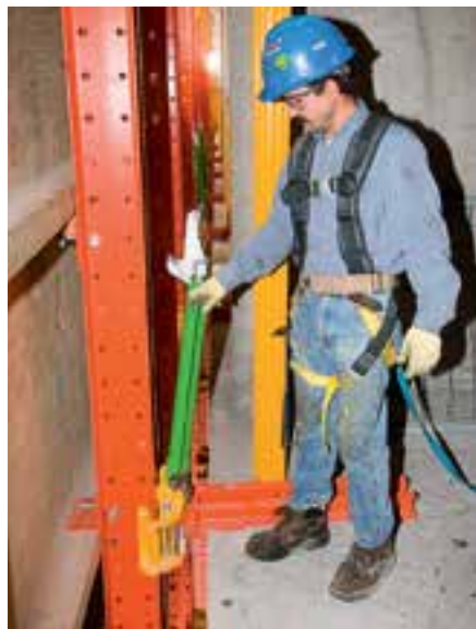
Siłownik hydrauliczny o nośności 5 ton montuje się na uchwycie wspinania.
