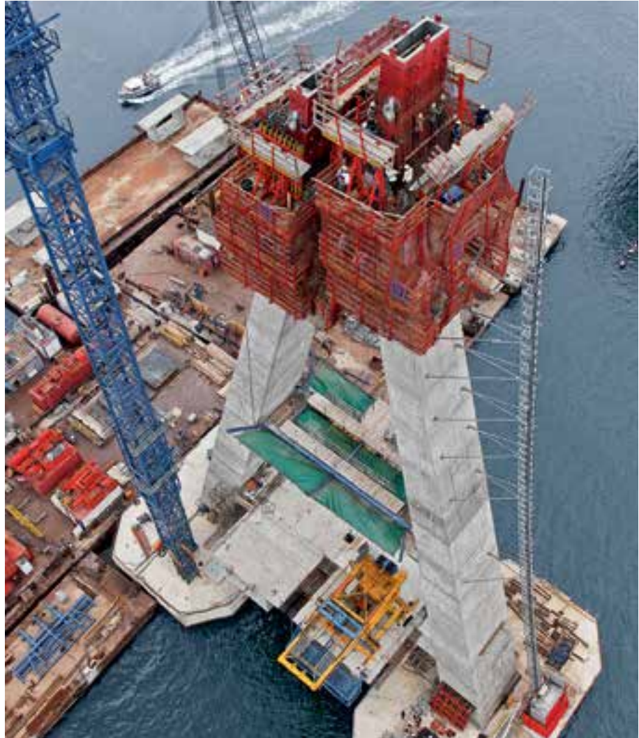
Na potrzeby realizacji pylonu mostu w Nigerii firma PERI połączyła systemy ACS i RCS. Prace wykonywane bez użycia żurawia zapewniały szybki postęp robót pomimo zmieniającego się nachylenia pylonów.
