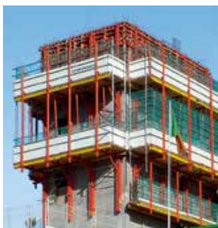
System szynowy wspinania RCS pozwala na użycie różnych systemów deskowań ściennych, m. in. sprawdzonego deskowania ramowego TRIO.
