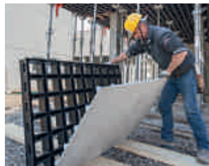
2. Usunięcie uszkodzonego poszycia
