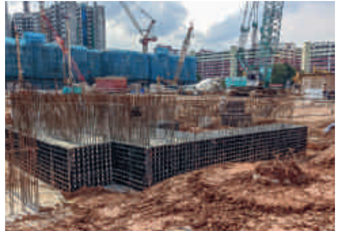
Mniejsze nakłady związane z czyszczeniem deskowań i wykańczaniem powierzchni betonu.
