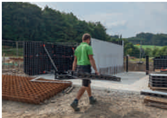
Początkujący "cieśle" z firmy zajmującej się wykonawstwem obiektów małej architektury wykorzystują DUO do formowania boksów na żwir.
