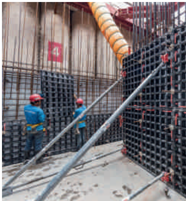
Niewielki ciężar, mały format płyt - te zalety DUO dały swój pełny wyraz przy wykonywaniu ścian podziemnych.
