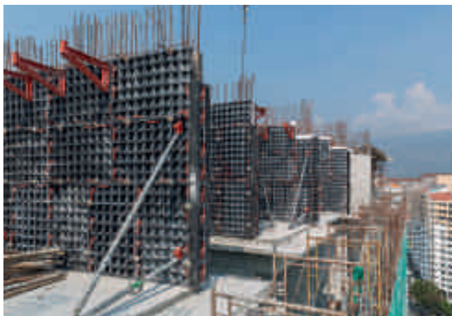
Udane pierwsze użycie lekkiego deskowania systemowego do ścian.
