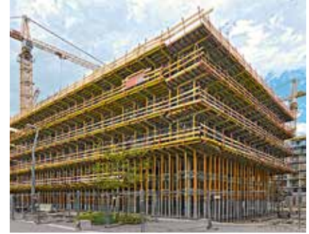
Rozwiązanie PERI bazujące na systemach MULTIPROP i MULTIFLEX umożliwiło deskowanie balkonów, jednocześnie spełniając funkcję rusztowania roboczego.
