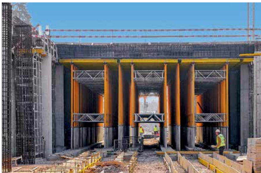
Wieże podporowe są ekonomiczną alternatywą dla tradycyjnego rusztowania podporowego, szczególnie w przypadku stropów na dużej wysokości.
