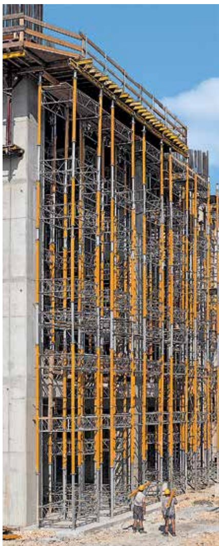
Wieże MULTIPROP jako rusztowanie podpierające wspornikową płytę stropową na wysokości 20 m.
