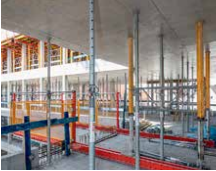
Szyny RCS pomostu wysuwanego RCS MP były dociśnięte do podłoża podporami MULTIPROP, rozpartymi między dwoma stropami.
