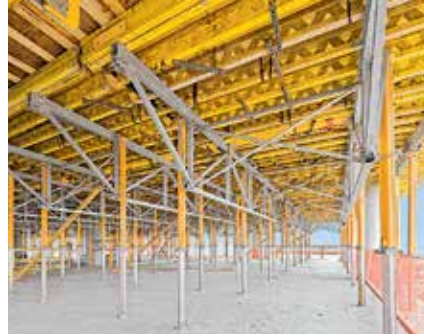
Podpory MULTIPROP w kombinacji z dużymi stołami stropowymi SKYTABLE umożliwiają szybsze cykle robocze i gwarantują wyższy poziom bezpieczeństwa.
