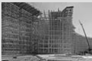
Rusztowania podporowe
