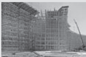
Rusztowania podporowe
