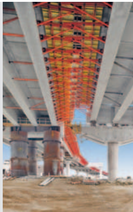
Obiekty o konstrukcji częściowo prefabrykowanej Most Golden Ears, Kanada Dźwigar prefabrykowany z płytą realizowaną „in situ”
