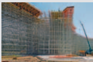
Rusztowania podporowe
