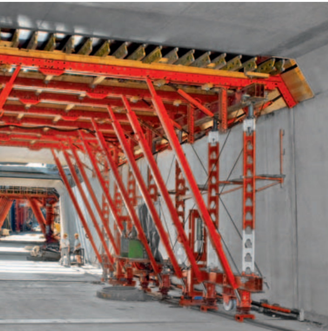
Podpory wysokońskie HD 200 wbudowane w urządzeniu przejezdnym do wykonywania stropu przejmują obciążenia z realizacji tego tunelu wykonywanego w metodzie odkrywkowej.
