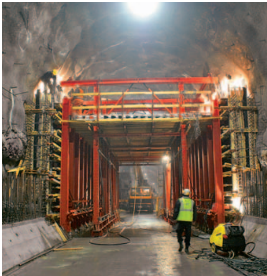
Pierwszy etap z płytą fundamentową i starterami został już zabetonowany.
