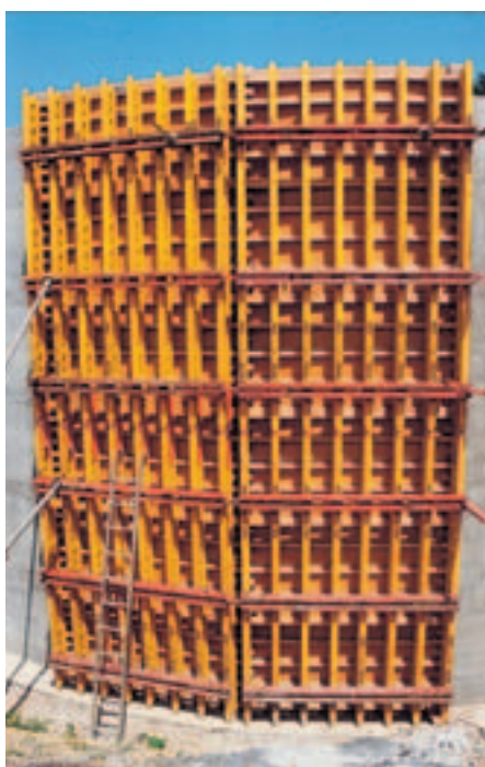
Deskowanie łukowe o wysokości 7,50 m z krążnikami na dźwigarach GT 24.
