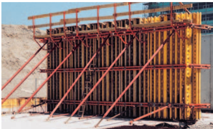
VARIO o wysokości 4,20 m z zamontowanym deskowaniem czołowym.
