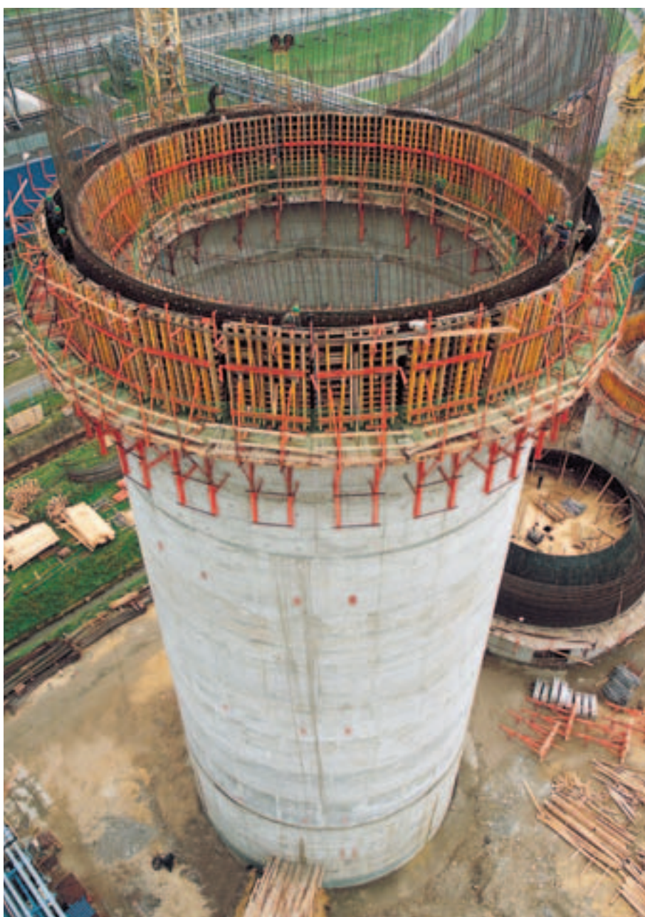
Silos w Opolu, h = 72 m, \varnothing = 20 m. Zadeskowany łukowym deskowaniem dźwigarowym VARIO ustawionym na pomostach roboczych KGF.
