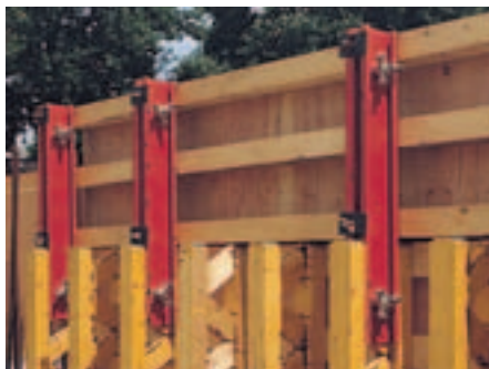
60-cm nadstawka wykonana z krawędziaków. Łącznik nadstawczy VARIO 24 ułatwia pracę.
