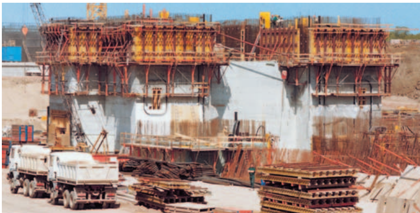
Kompletna jednostka: VARIO GT 24 na jednostronnym pomoście roboczym SKSF 240.
