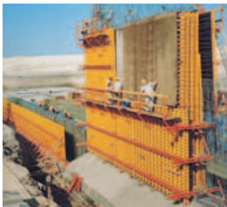
Dźwigarowy system deskowań ściennych VARIO GT 24 wyposażony jest w bezstopniowe łączniki z podłużnymi otworami.
