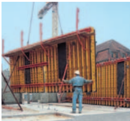
VARIO GT 24 w budownictwie mieszkaniowym.
