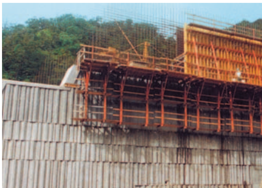
Portal tuneli na Hawajach. Deskowanie VARIO GT 24 na pomostach roboczych KGF 240.
