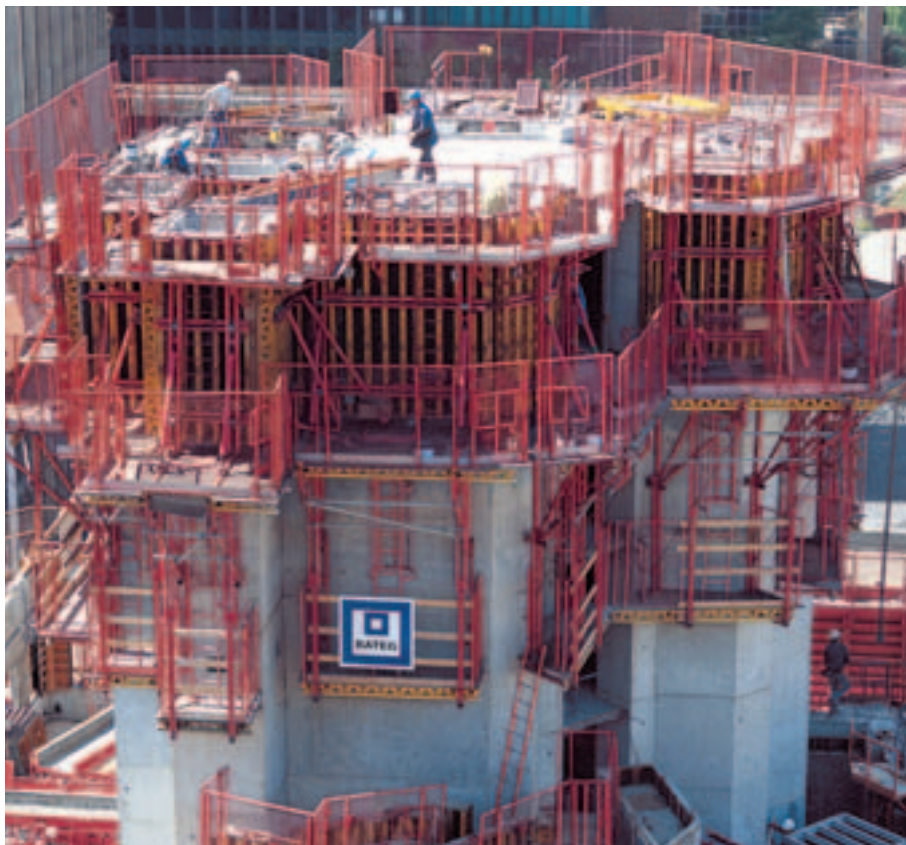
Budynek wysoki w Paryżu deskowany w VARIO GT 24 na pomostach roboczych CB 240.
