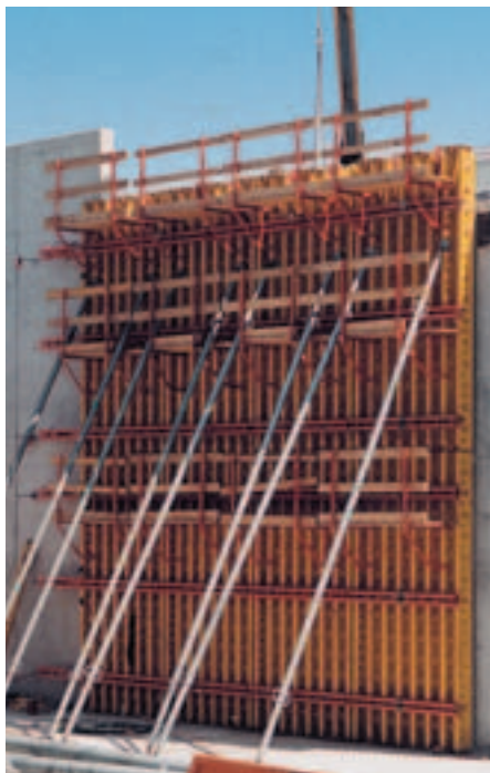
Nadstawiane płyty VARIO GT 24 przy budowie obiektu administracyjnego.
