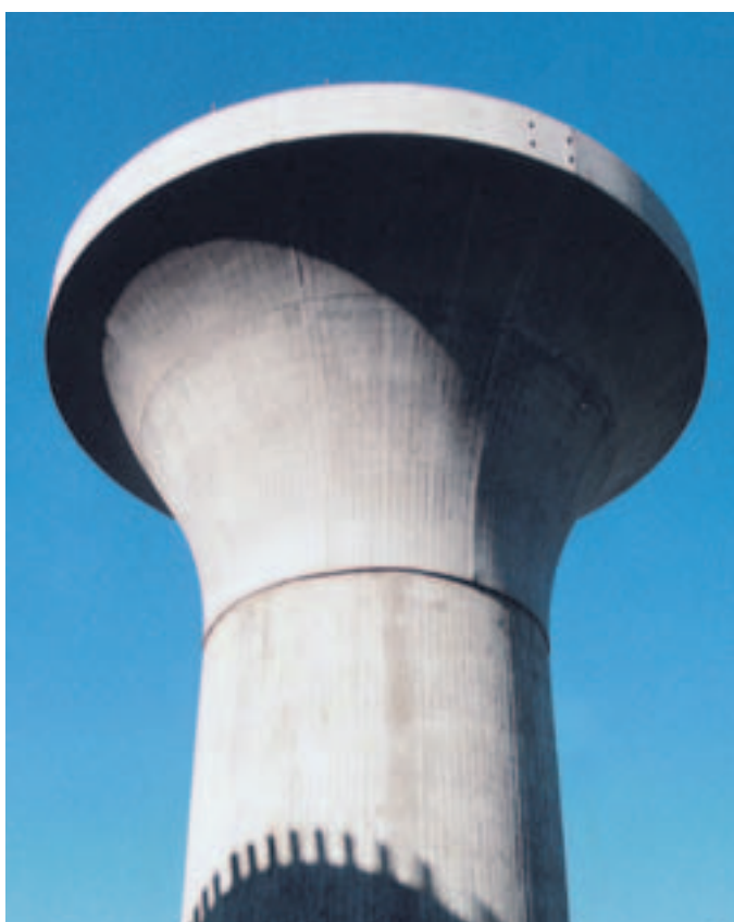
Wiadukt nad doliną Triebischbach, autostrada BAB 4. Filary o wysokości do 49 m i głowicach w kształcie trąbki.
