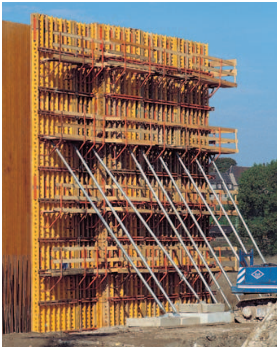
Deskowanie ściany VARIO o wysokości 10,70 m, dwukrotnie nadstawione w pozycji pionowej.
