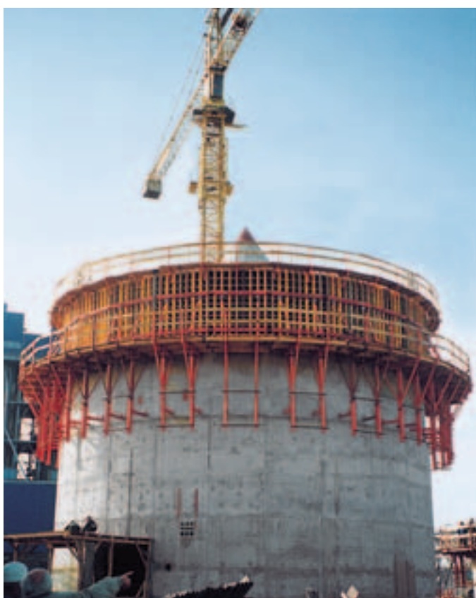
VARIO GT 24 na budowie zbiornika okrągłego. Drewniane kliny pomiędzy dźwigarami i ryglami stalowymi nadają łukowy kształt.
