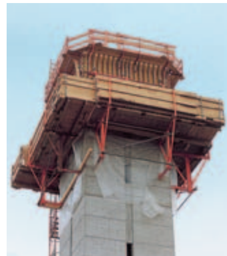
Wieża kościelna w Feldmoching koło Monachium. VARIO GT 24 na pomostach roboczych KGF 240.
