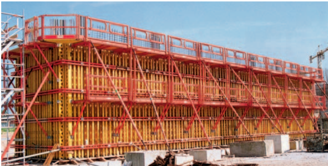
Standardowe płyty VARIO GT 24 o wysokości 6,00 m z pomostami roboczymi.
