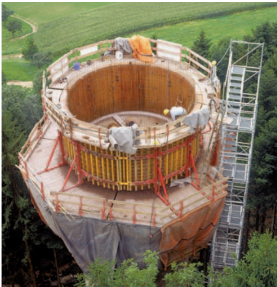
Deskowanie łukowe GRV na pomostach roboczych KGF 240
