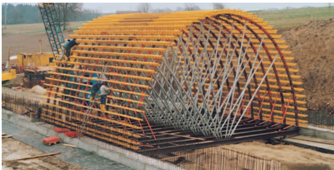
Deskowanie sklepienia o szerokości 13,50 m i wysokości 8,40 m. Rygle przegubowe GRV z dźwigarami GT 24 podparte zastrzałami RS 1000.
