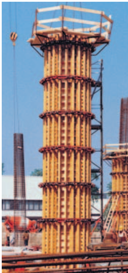
Kompletny zbiornik okrągły zadekowany z GRV bez użycia ściągnięć.
