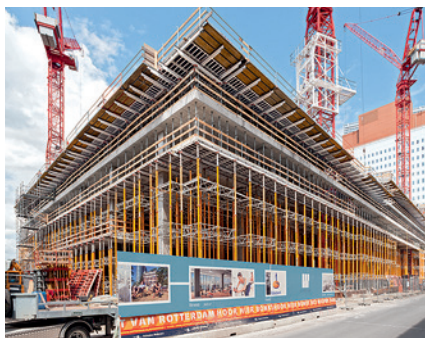
Wysoki poziom bezpieczeństwa na krawędzi stropu
