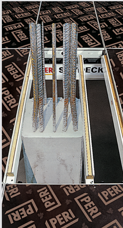
Do deskowania wokół słupa wykorzystuje się dźwigary brzegowe SKYDECK SRT 150 lub SRT 75.
