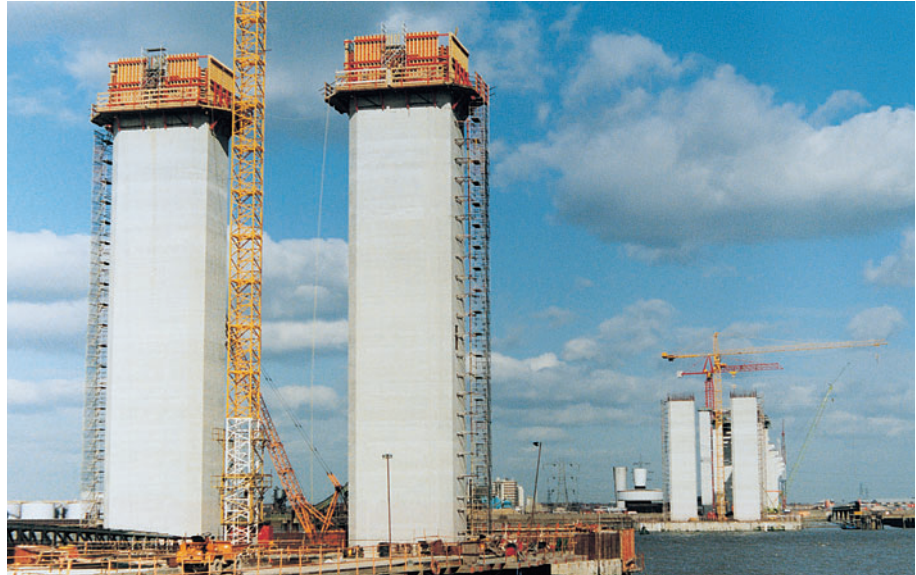
CB 240 z VARIO GT 24 przy budowie filarów mostu.
