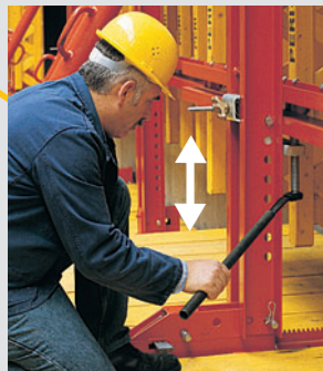
Regulacja położenia w pionie Przy VARIO GT 24 za pomocą rektyfikatora
