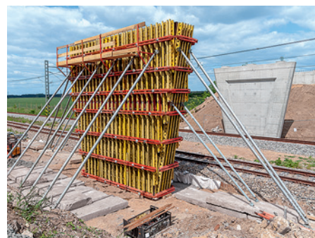
Przykład użycia z deskowaniem VARIO GT 24 Pylon mostowy, tor testowy Instytutu Kolejnictwa (VUZ), Czechy
