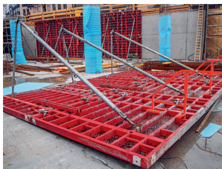
Łatwy i bezpieczny montaż zastrzałów i rozpór na leżącym deskowaniu, ...
