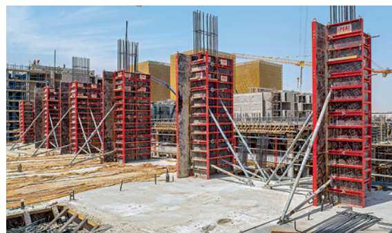
Przykład użycia z deskowaniem słupowym ITCC Phase II, Rijad, Arabia Saudyjska
