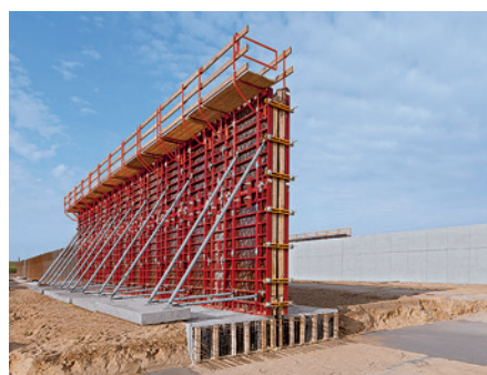
Przykład użycia z deskowaniem TRIO Magazyn biomasy, Cukrownia Anklam, Niemcy
