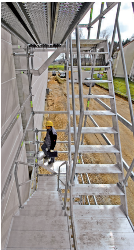
Dopasowania wysokości na wspornikach nie powodują zablokowania podestów podczas wchodzenia i schodzenia.
