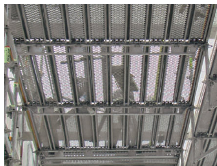
Platforma kompletnie zakryta podestami systemowymi PERI UP.
