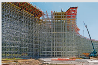
Rusztowania podporowe
