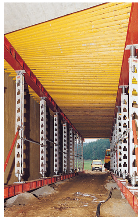
60 mb ustroju nośnego wiaduktu na HD 200.
