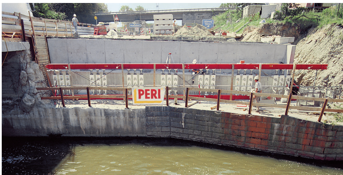
Zastosowanie podpory wysokościowej HD 200 jest również opłacalne przy niewielkich wysokościach.
