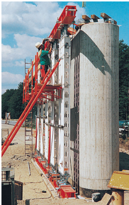
Wspornik pomostu roboczego HD 75 zapewnia szerokość roboczą 75 cm. Dopuszczalny rozstaw: 1,25 m. Obciążenie użytkowe: 150 kg/m 2
