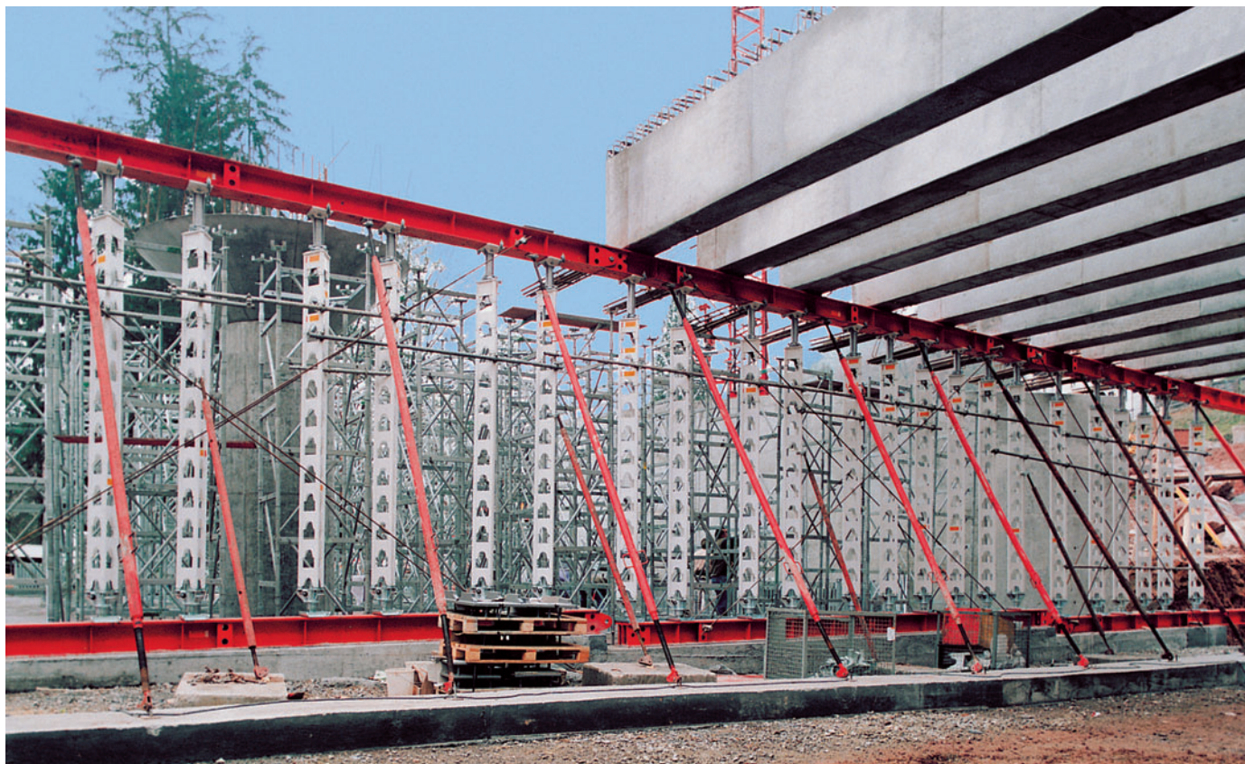
Wspornik pomostu roboczego HD 75 zapewnia szerokość roboczą 75 cm. Dopuszczalny rozstaw: 1,25 m. Obciążenie użytkowe: 150 kg/m 2
