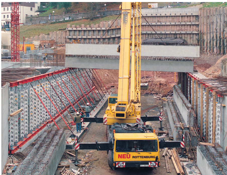
System PERI HD 200 jako rusztowanie podporowe prefabrykowanych belek sprężonych.
