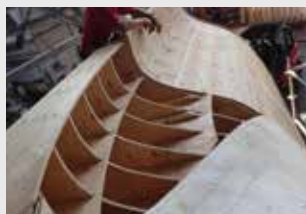
Konstrukcja deskowania
