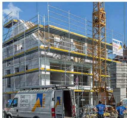
Realizacja budynku biurowo-mieszkalnego, Frickenhausen, Niemcy
