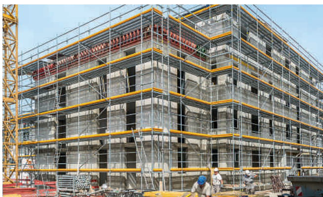
Budowa osiedla mieszkalnego przy Killisfeldstraße, Karlsruhe, Niemcy
