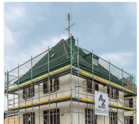
Remont kamienicy, Landau, Niemcy
