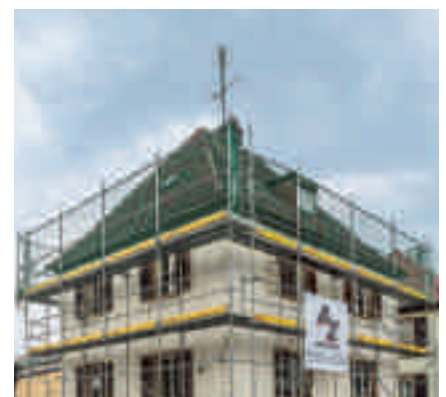
Remont kamienicy, Landau, Niemcy
