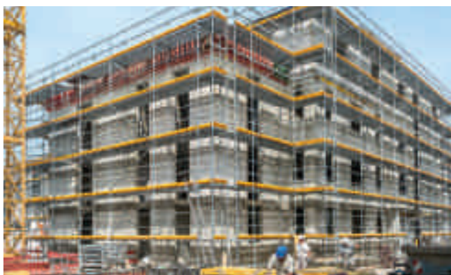
Budowa osiedla mieszkalnego przy Killisfeldstraße, Karlsruhe, Niemcy
