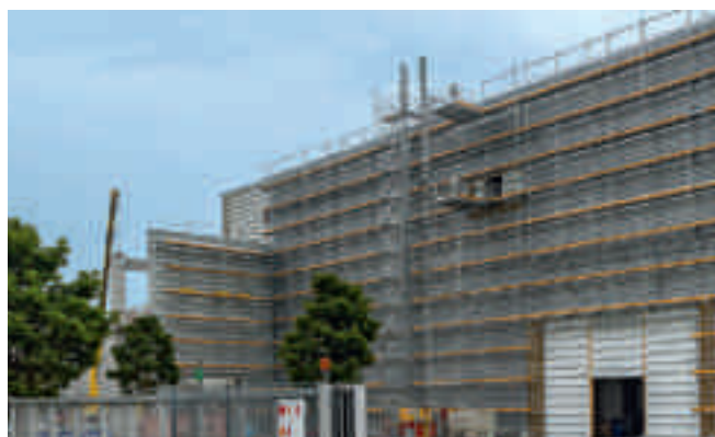
Rozbudowa zakładu półprzewodników firmy Zeiss, Oberkochen, Niemcy
