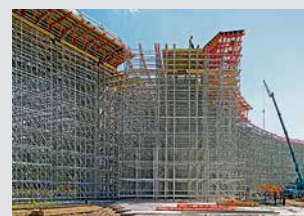
Rusztowania podporowe
