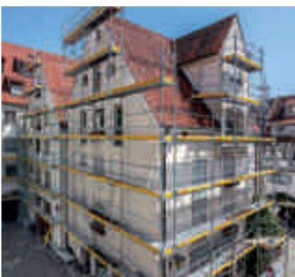
Renowacja domu wielorodzinnego, Ulm, Niemcy
